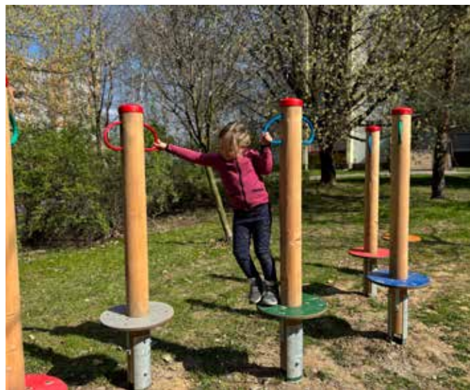
Opravené pískoviště, pružinové houpačky a dva balanční prvky vítají děti u domů v ulicích Břenkova a Horymírova. Prvky už vybízejí ke hrám. Na místě přibude ještě dřevěný domeček, na jehož realizaci se pracuje.
