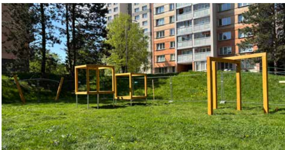
Poslední část projektu 3 v 1 se nachází v ulici Výškovická 174. Hřiště pro nejmenší děti bude do léta hotové. Už se zde staví domečky se skluzavkami a houpačky.
